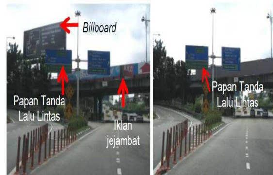
Perletakan papan iklan luar yang mengganggu pandangan pengguna jalan raya terhadap papan tanda lalu lintas tidak dibenarkan.
