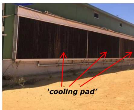
Gambar 7: Penggunaan air bagi tujuan membasahkan cooling pad pada dinding reban bagi menyejukan suhu dalam reban.
