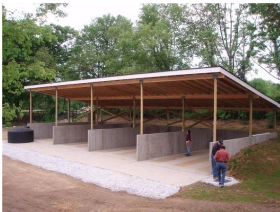
Gambar 9: Ruang pengkomposan sisa ternakan secara bangsal terbuka.
