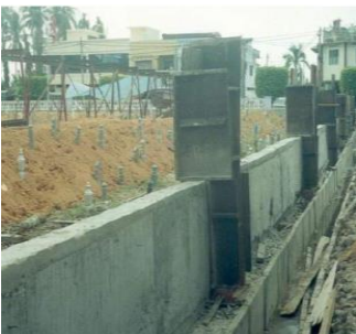
Pembinaan struktur tembok penahan dan sistem saliran air bawah tanah di perkuburan sedia ada
